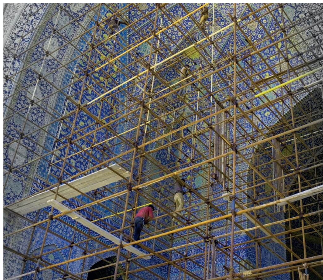
Échafaudage pour la restauration d'un iwan de la mosquée du Chahai à Isfahan, A. Menades, 2017
